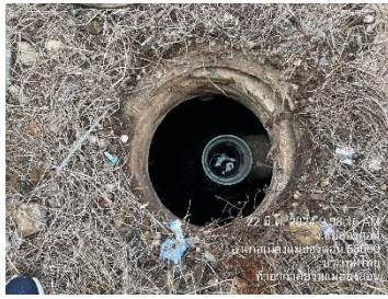
บ่อบำบัดน้ำหลังผ่านระบบบำบัดน้ำเสียสำเร็จรูปของอาคารผู้โดยสารขาเข้า จุดที่ 3
