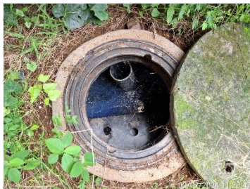
บ่อพักน้ำหลังผ่านระบบบำบัดน้ำเสียสำเร็จรูปของอาคารผู้โดยสารขาเข้า จุดที่ 2
