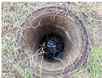
บ่อบำบัดน้ำหลังผ่านระบบบำบัดน้ำเสียสำเร็จรูปของอาคารทำการดับเพลิงและหน่วยกู้ภัยทางด้านขวามือ
