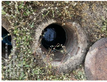
บ่อบำบัดน้ำก่อนเข้าระบบบำบัดน้ำเสียสำเร็จรูปของอาคารผู้โดยสารขาเข้า จุดที่ 1
