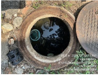
บ่อบำบัดน้ำก่อนเข้าระบบบำบัดน้ำเสียสำเร็จรูปของอาคารผู้โดยสารขาออก จุดที่ 2
