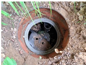
บ่อบำบัดน้ำก่อนเข้าระบบบำบัดน้ำเสียสำเร็จรูปของอาคารผู้โดยสารขาออก จุดที่ 3
