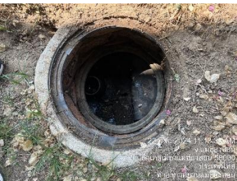
บ่อบำบัดน้ำหลังผ่านระบบบำบัดน้ำเสียสำเร็จรูปของอาคารผู้โดยสารขาออก จุดที่ 3
