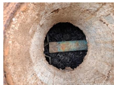
บ่อบำบัดน้ำก่อนเข้าระบบบำบัดน้ำเสียสำเร็จรูปของอาคารทำการดับเพลิงและหน่วยกู้ภัยทางด้านซ้ายมือ
