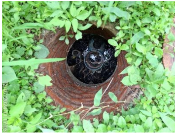
บ่อพักน้ำก่อนเข้าสู่ระบบบำบัดน้ำเสียสำเร็จรูปของอาคารผู้โดยสารขาเข้า จุดที่ 1
