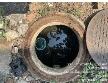
บ่อบำบัดน้ำก่อนเข้าระบบบำบัดน้ำเสียสำเร็จรูปของอาคารหอบังคับการบิน
