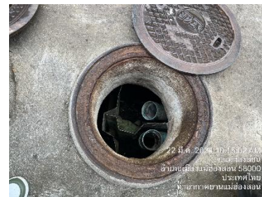
บ่อบำบัดน้ำหลังผ่านระบบบำบัดน้ำเสียสำเร็จรูปของอาคารทำการดับเพลิงและหน่วยกู้ภัยทางด้านซ้ายมือ
