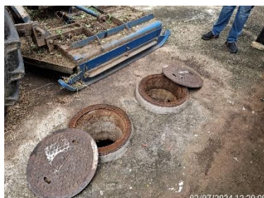
บ่อบำบัดน้ำก่อนเข้าระบบบำบัดน้ำเสียสำเร็จรูปของอาคารทำการดับเพลิงและหน่วยกู้ภัยทางด้านซ้ายมือ
