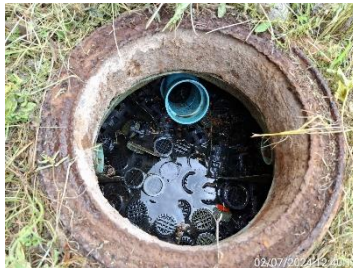
บ่อบำบัดน้ำหลังผ่านระบบบำบัดน้ำเสียสำเร็จรูปของอาคารหอบังคับการบิน
