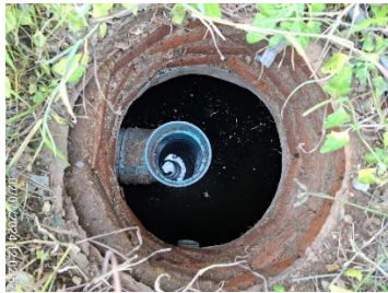
บ่อบำบัดน้ำก่อนเข้าระบบบำบัดน้ำเสียสำเร็จรูปของอาคารผู้โดยสารขาออก จุดที่ 1
