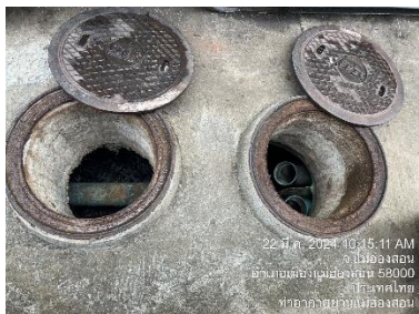
บ่อบำบัดน้ำหลังผ่านระบบบำบัดน้ำเสียสำเร็จรูปของอาคารทำการดับเพลิงและหน่วยกู้ภัยทางด้านซ้ายมือ
