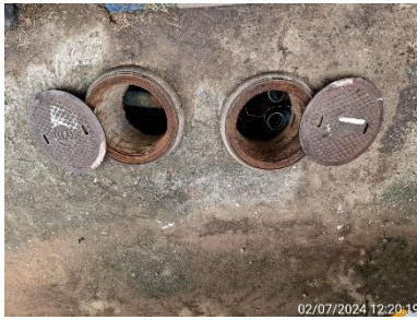
บ่อพักน้ำหลังผ่านระบบบำบัดน้ำเสียสำเร็จรูปของอาคารที่ทำการดับเพลิงและหน่วยกู้ภัยทางด้านซ้ายมือ
