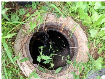
บ่อพักน้ำก่อนเข้าสู่ระบบบำบัดน้ำเสียสำเร็จรูปของอาคารผู้โดยสารขาเข้า จุดที่ 2
