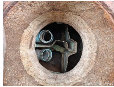
บ่อพักน้ำหลังผ่านระบบบำบัดน้ำเสียสำเร็จรูปของอาคารที่ทำการดับเพลิงและหน่วยกู้ภัยทางด้านซ้ายมือ
